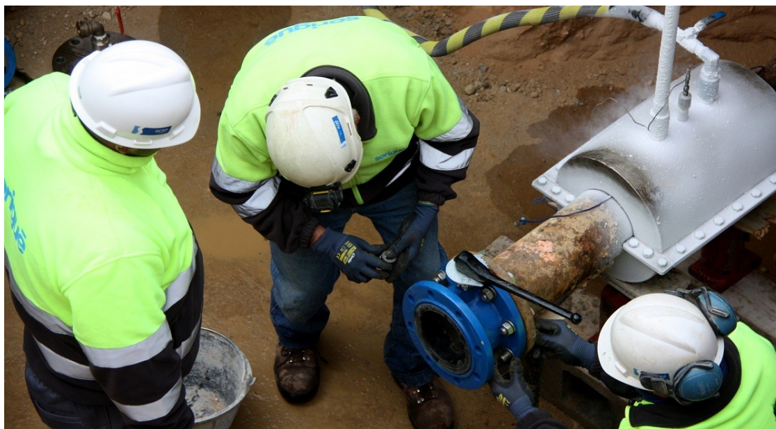
Recanvi d'una vàlvula després de la creació del tap de gel a l'interior. | ACN
