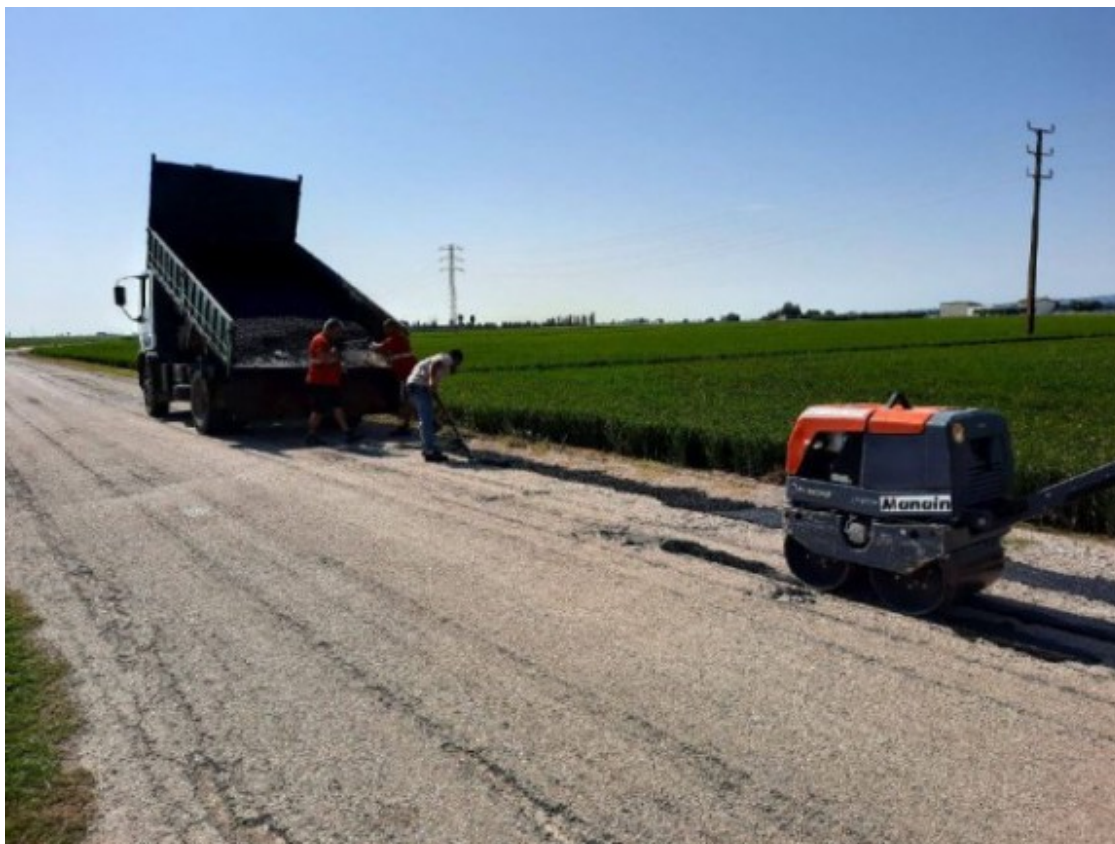
Arranjaments dels camins del Delta per part de l'Ajuntament d'Amposta Foto: Ajuntament d'Amposta
