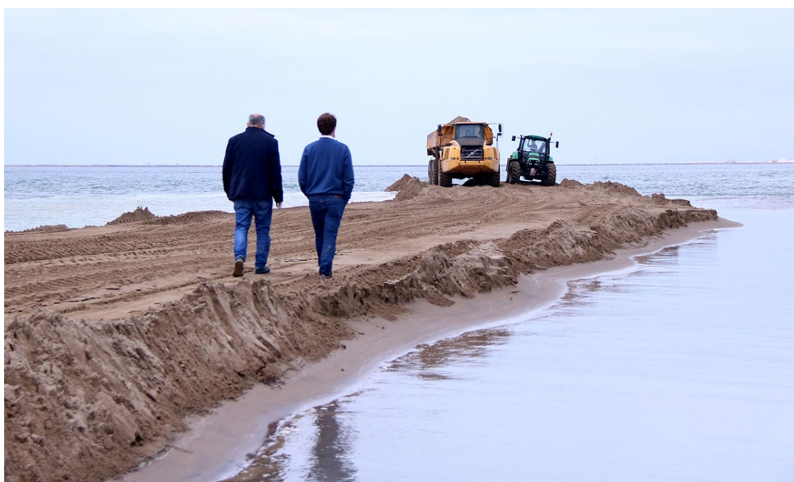
El treballs de reconstrucció de la barra del Trabucador, al juliol del 2020. | ACN
