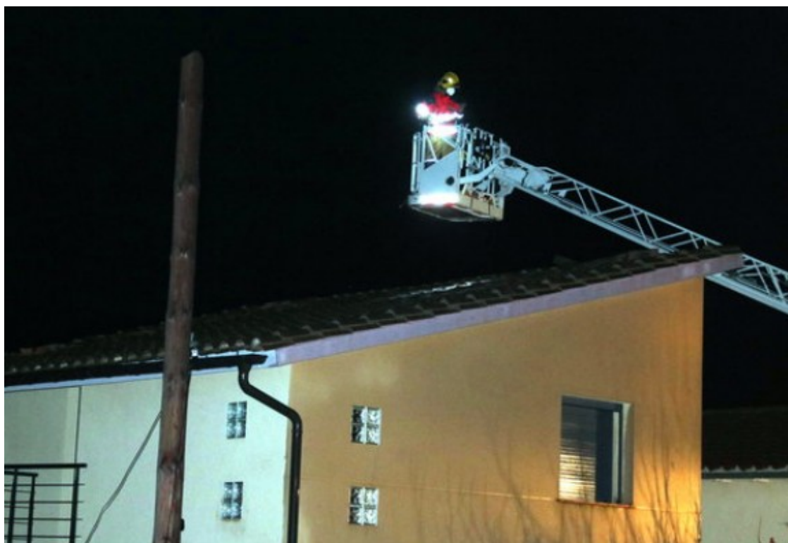
Pla general dels Bombers comprovant amb una grua l'estat de les teulades de les cases per on ha passat l'esclafit Foto: ACN
