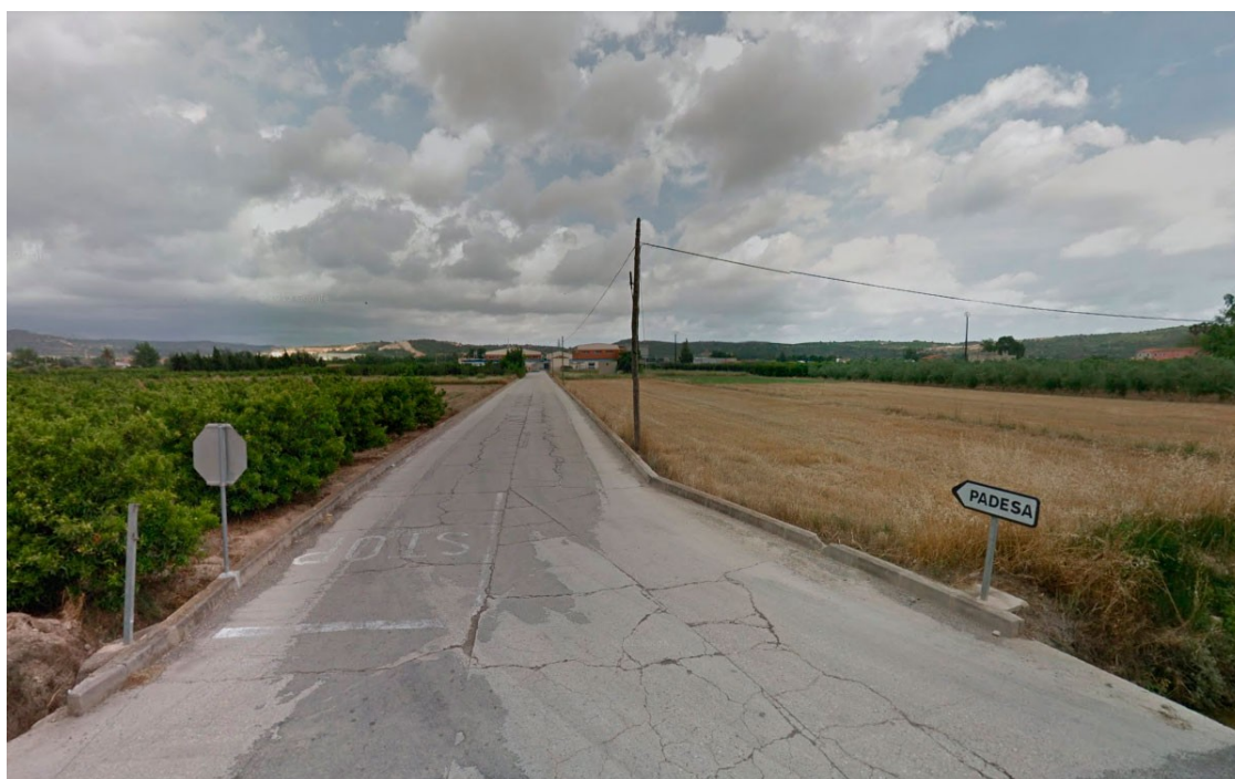
Accés a la planta de Padesa a Amposta. | Google maps
