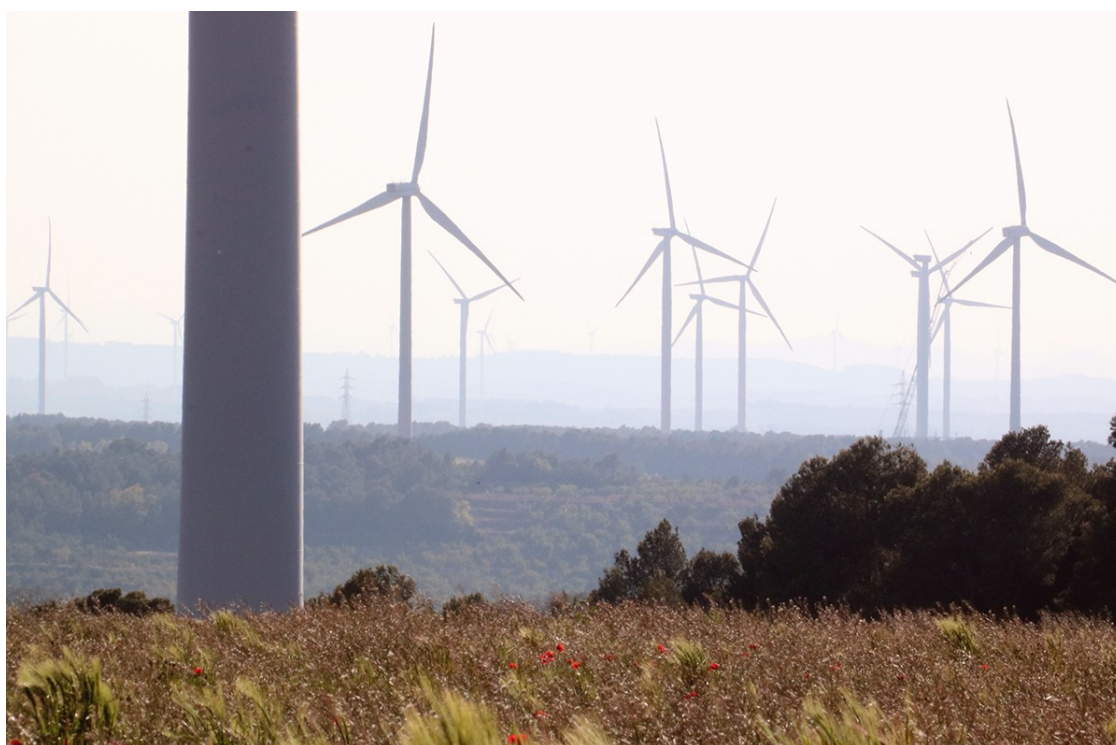
Alguns dels aerogeneradors instal·lats a l'altiplà de la Terra Alta. | ACN
