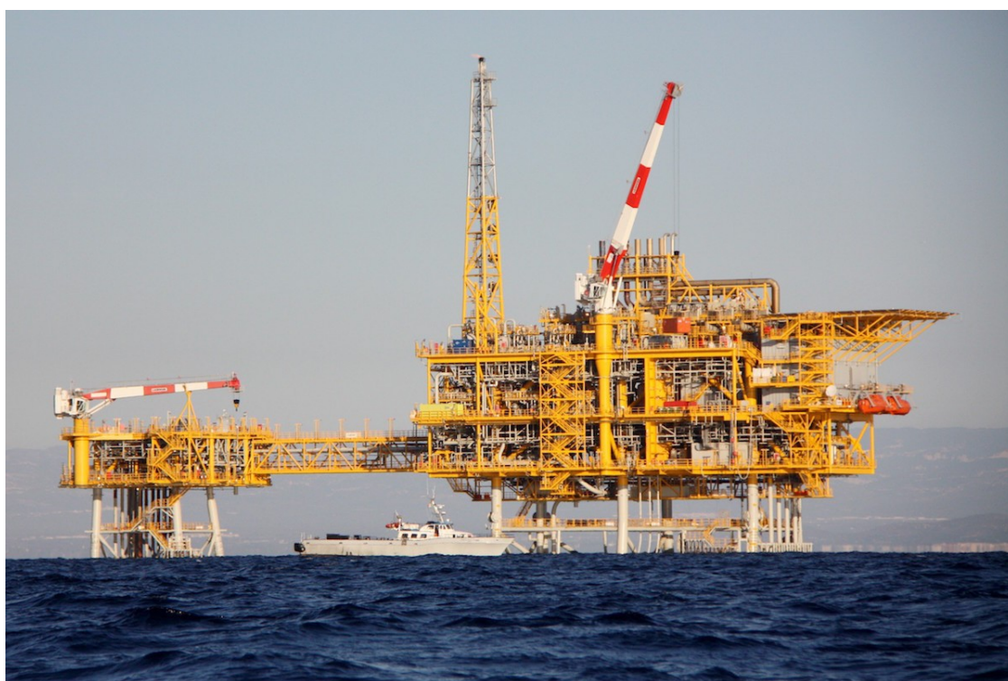
La plataforma Castor, vista des de la costa del Montsià. | ACN
