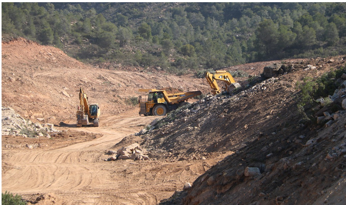
Les obres de l'abocador de Riba-roja. | ACN / Mar Rovira
